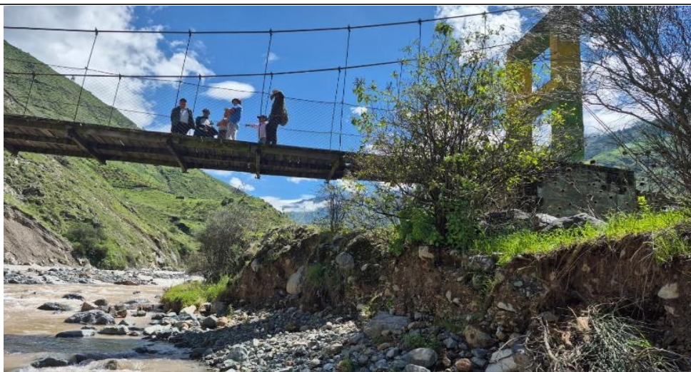
FOTOGRAFIA N°02: TRAMO CRÍTICO EN EL RÍO CHIRIS, ENCONTRÁNDOSE SOCAVADO EL TALUD Y EXPUESTO A PELIGRO EL PUENTE PEATONAL
